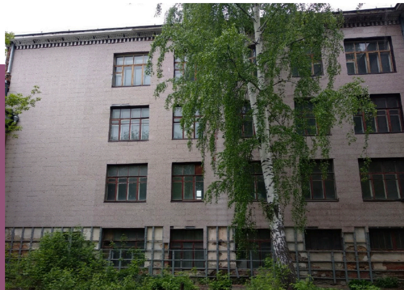
Фото 2. Фрагмент главного фасада объекта
